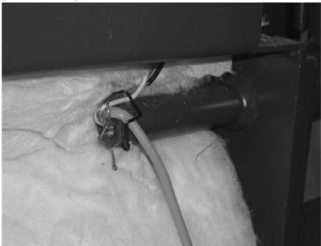
Pavaizduotas vandens temperatūros jutiklis (TK) katile – katilai su degikliais duryse – DCxxS(X), CxxS, ACxxS, DCxxRS
