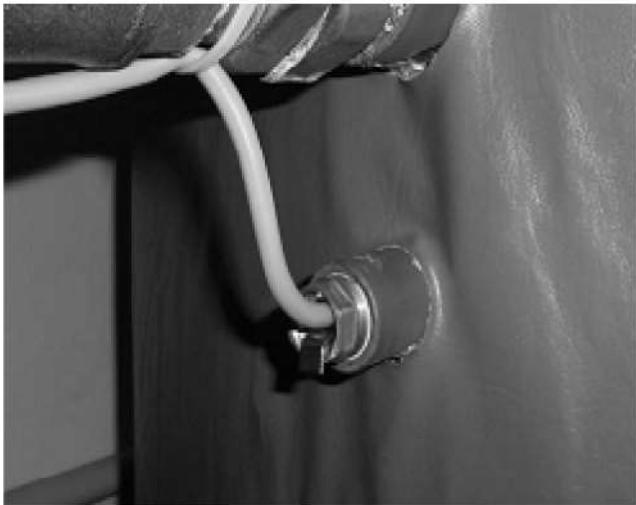
Pavaizduotas vandens temperatūros jutiklis įmontuotas į akumuliacinę talpą (TV ir TS)
